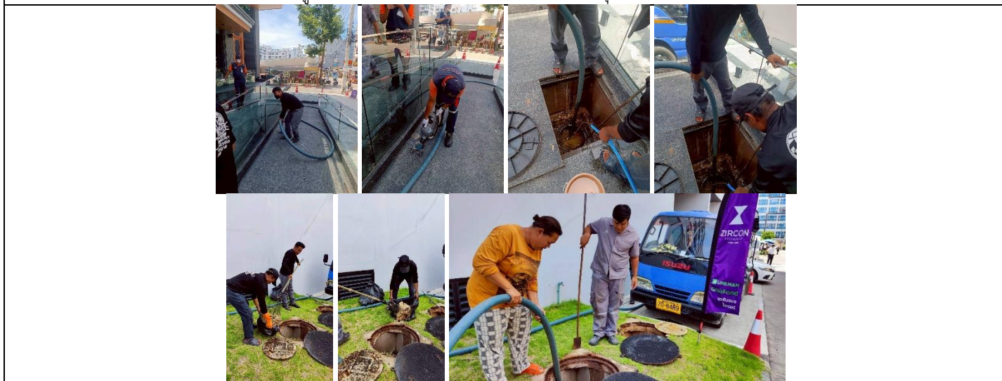
รูปที่ ๗7.57 การสูบน้ำส่วนเกินออกจากถังบำบัดน้ำเสีย (ก.ย.68)
