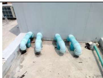
รูปที่ ผ7.48 ท่อระบายก๊าซมีเทน
