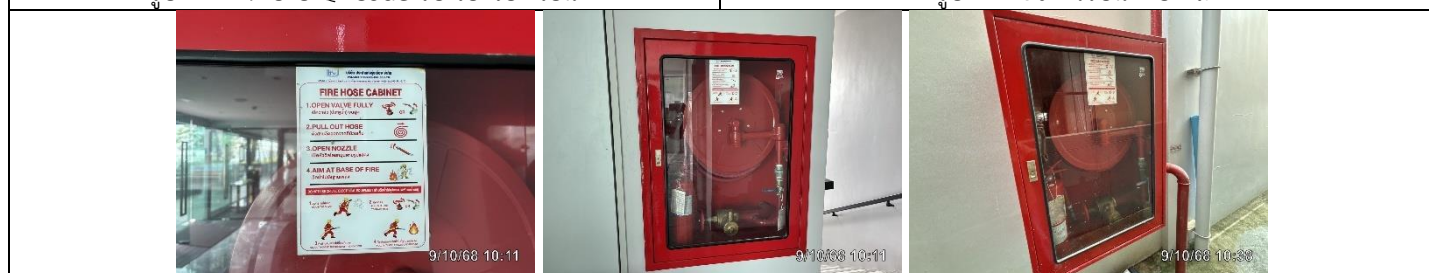
รูปที่ ผ7.31 ตู้สายน้ำดับเพลิง
